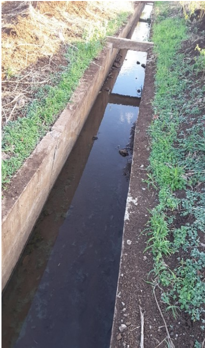
Picha 6.1: Athari ya udongo mweusi iliyosababisha sehemu ya ukuta wa mfereji wa skimu ya Themu ya Simba kupinda kuelekea ndani. Picha imepigwa na mkaguzi tarehe 26 Novemba, 2018
